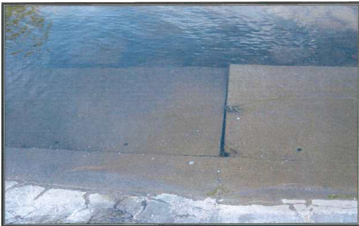
Photographie 15 : Affaissement d'une dalle de béton
