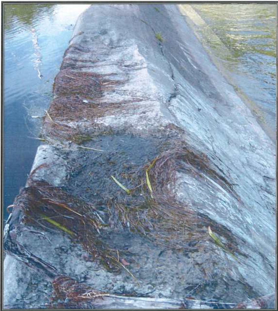
Photographie 13 : Calotte de béton manquante
