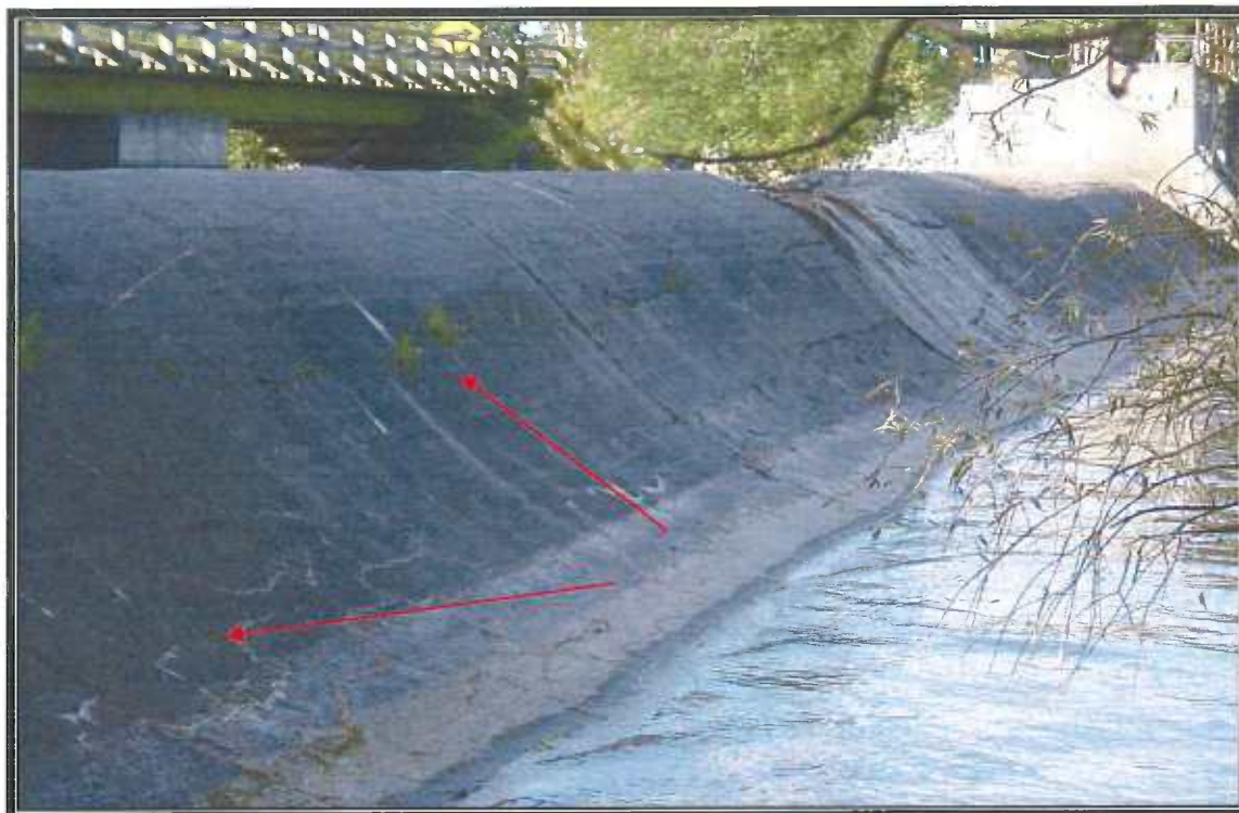
Photographie 11 : Réseau de fissures longitudinales
