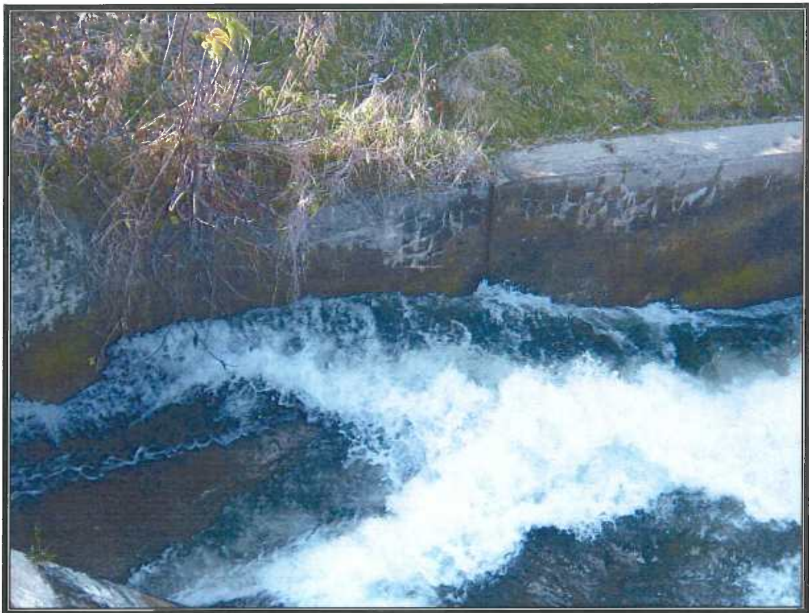
Photographie 5 : Eau frappant le mur de soutènement en rive gauche lors de sa sortie des vannes d'évacuation
