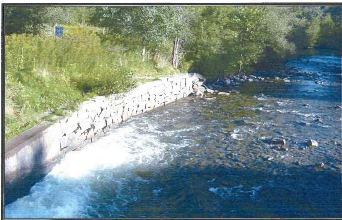
Photographie 4 : Section aval en rive gauche du mur de soutènement constituée de blocs
